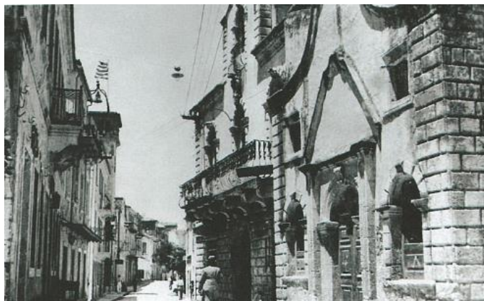
Σχ. 3: Οικία κόντε Καίσαρα Μεταξά. Λιθόστρωτο Αργοστολίου [7].
